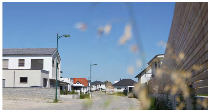
Wohngebiet Scheidäcker: Die Bauarbeiten befinden sich in der finalen Phase.
