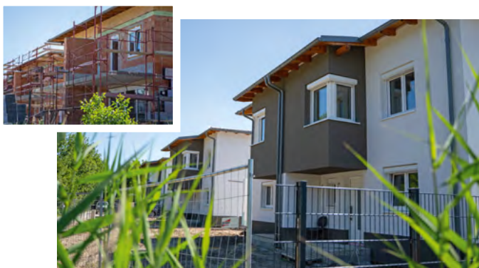
18 Reihenhäuser entstehen im Baugebiet Seepark. Acht davon sind bereits fertig, die restlichen zehn befinden sich in Bau.
