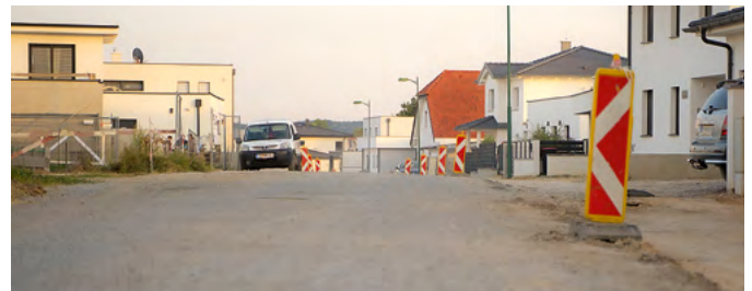
Wohngebiet Scheidäcker: Die Bauarbeiten befinden sich in der finalen Phase
