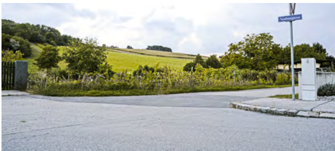
Die Kanalarbeiten an der Kreuzung Neubaugasse/Fabriksgasse sind bereits abgeschlossen
