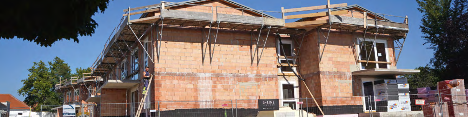
Baufortschritt beim Projekt „Betreutes Wohnen Plus“
