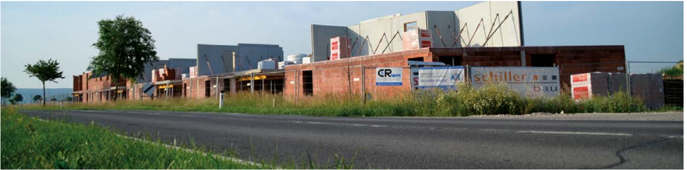
Zügiger Baufortschritt der OSG-Wohnungen im Gebiet der Scheidäcker. Im Anschluss an die Wohnungen werden Reihenhäuser errichtet.
